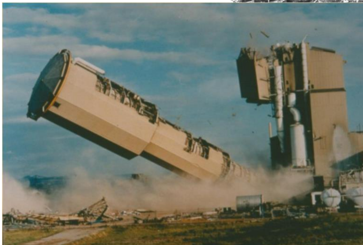
16. ábra Az ICI fermentor bontása
