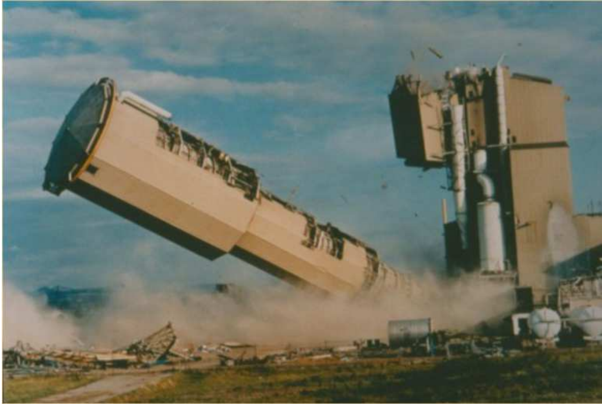
28. ábra Az ICI fermentor bontása
